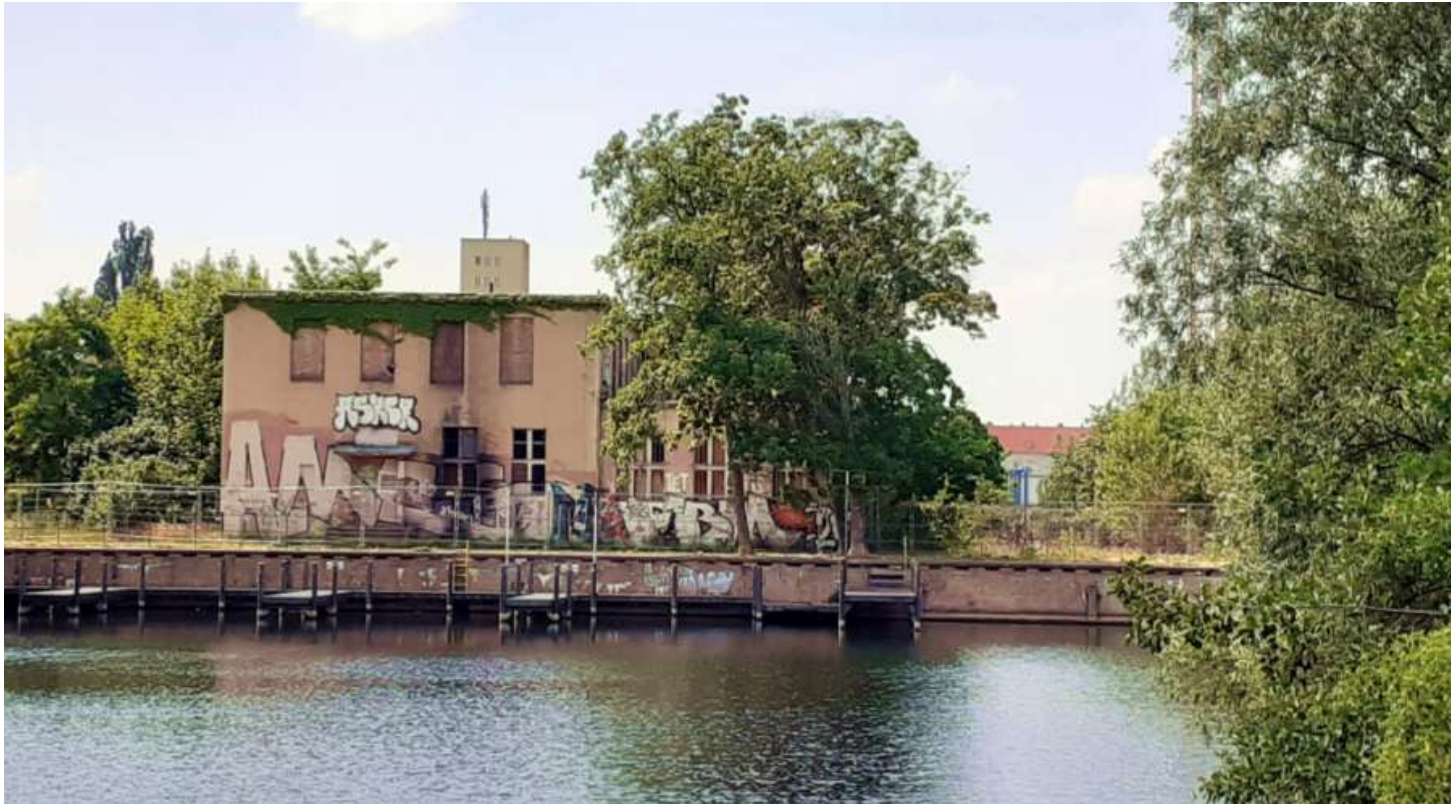
Das Baudenkmal „Am Maselakepark 44“ sollte im Febr. 2025 für über 12 Mio. Euro versteigert werden.
