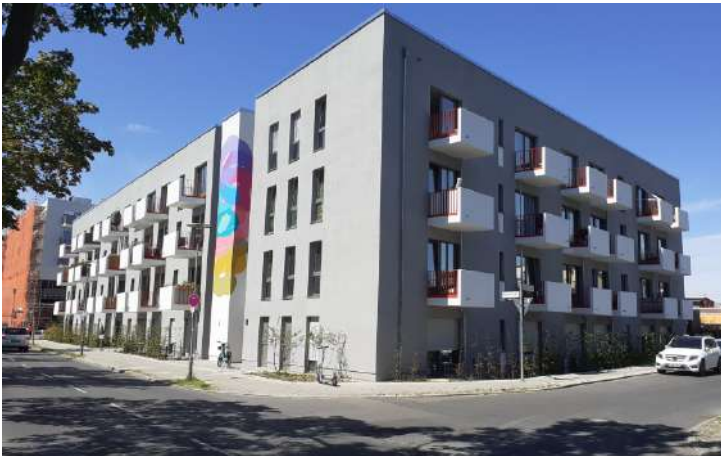
Das 2022 fertig gestellte Gewobag-Gebäude an der Rhenaniastraße 50 hat 71 neue Wohnungen.
