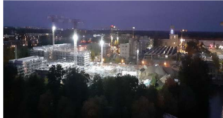
Das Baufeld im Maselakepark 1 Jahr nach Baubeginn
