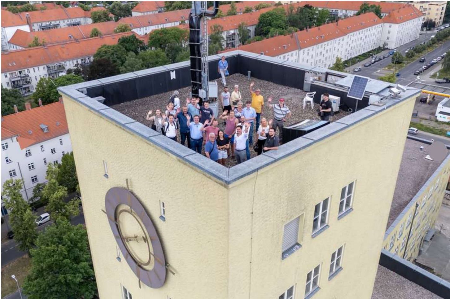
Auf dem Uhrenturm des ehem. Luftfahrtgerätewerks [Bezirksamt Spandau, 18.6.2025]
