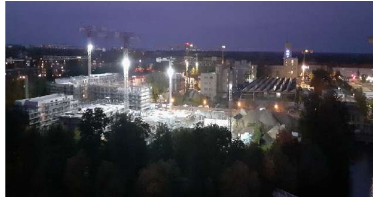
Das Baufeld im Maselakepark 1 Jahr nach Baubeginn
