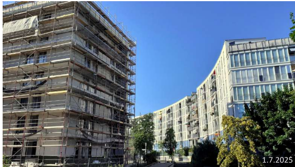
WBM-Rohbauten an der Rauchstraße, vor dem „Wasserbogen“.
