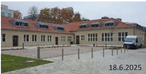
Das ehemalige Offizierskasino wurde denkmalgerecht saniert und ab Spätsommer 2025 mit dem Restaurant „qnorke“ und einer Kita betrieben. Des Weiteren wurden Co-Working-Spaces und Eventräume eingerichtet.
