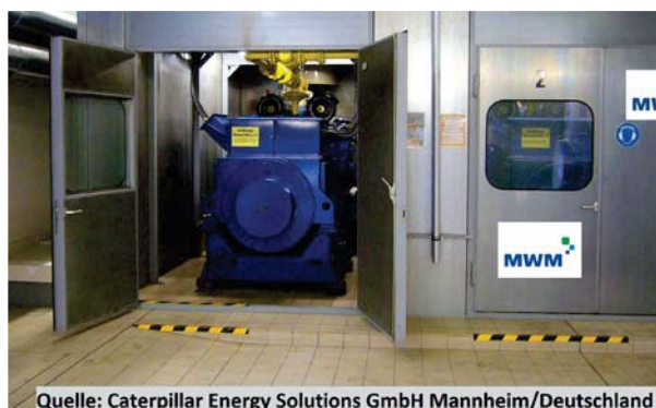
Abb. 67: eingebautes Blockheizkraftwerk
